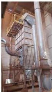
Ilustración 1. Filtro de proceso secadero de arcillas
